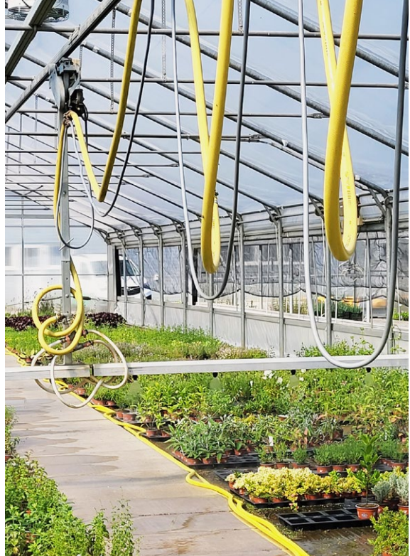
Die Überkopfbewässerung erleichtert in mittleren bis kleinen Betrieben die Giessarbeit.
