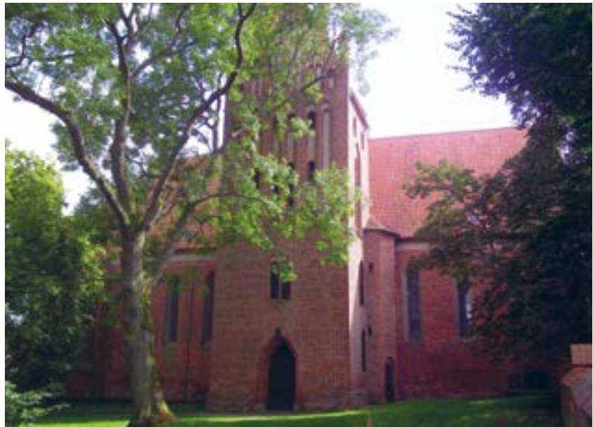
Die ehemalige Klosterkirche in Verchen ist ein frühgotischer Backsteinbau, Baubeginn um 1270. Der Turm wurde im 15. Jahrhundert errichtet.
